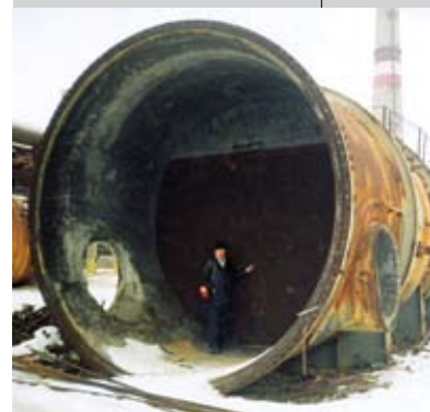
Очередной котел утилизатор для ремонта
